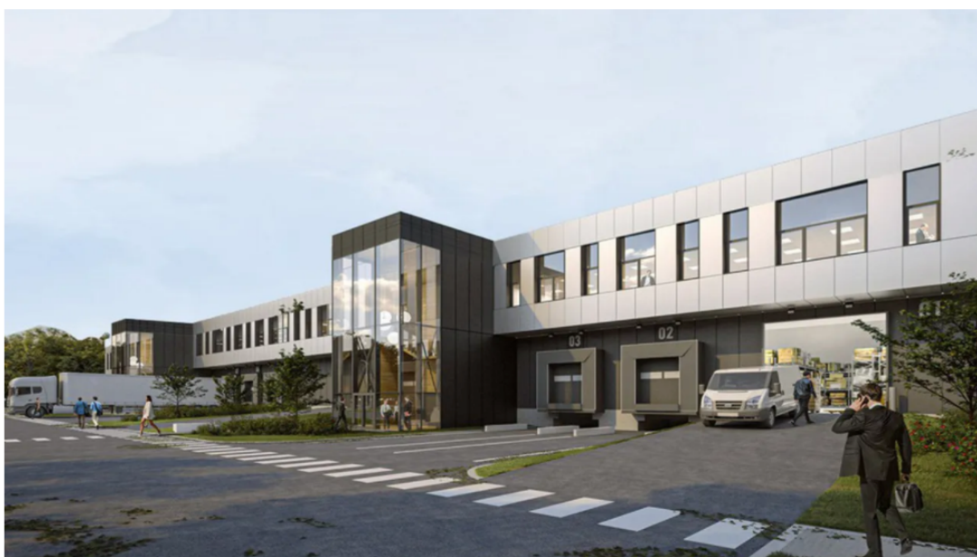
A la place de l'ancien siège social de Corsair à Rungis, un parc logistique va voir le jour. (Groupe Villa)
